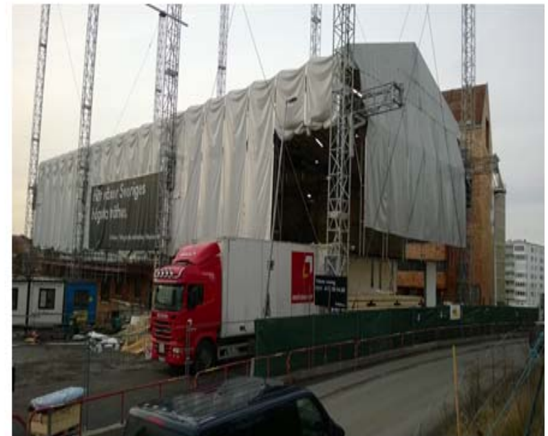
Materiaali suoraan sääsuojauksen sisälle, suoja nousee kerrosten rakentuessa ylöspäin
