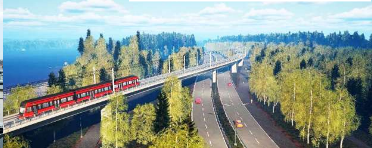
Raitiotien Linnainmaa-Pirkkala rakentaminen
